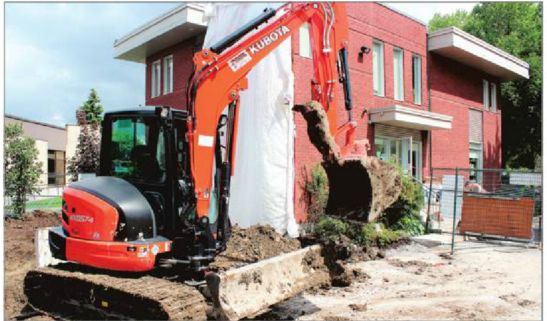
Le CAB Les P'tits bonheurs à Saint-Bruno installe des trappes pour sécuriser les dons des citoyens.
